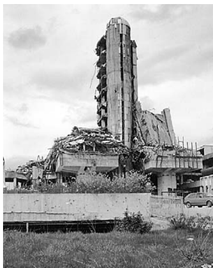
Les médias ont été une cible prioritaire durant la guerre. Ici, le bâtiment du quotidien de Sarajevo Oslobodjenje, bombardé lors du siège de la ville (1992-1995).
